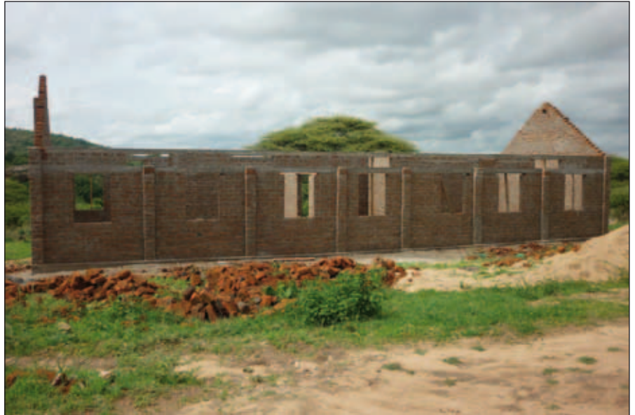
Das Mädchenhaus befindet sich bereits im Rohbau.
