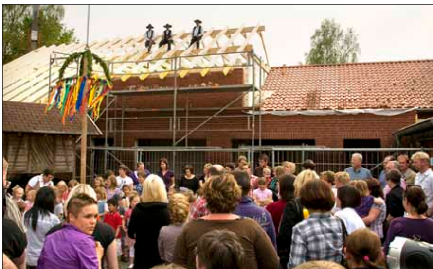
48 Jahre später: Richtfest für den neuen Anbau der KiTa.
