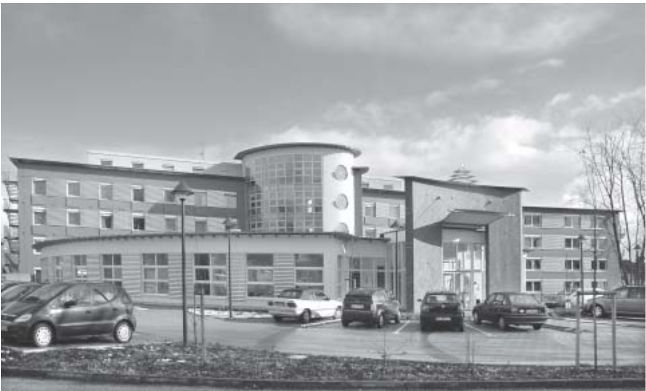
Vollständig umgestalteter Eingangsbereich des Stephanus-Hauses.
