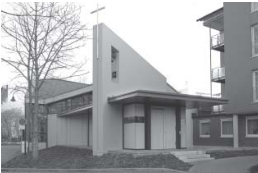
Die Kapelle des St. Bonifatius-Krankenhauses.
