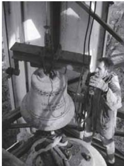
In schwindelerregender Höhe wird eine Glocke montiert.
