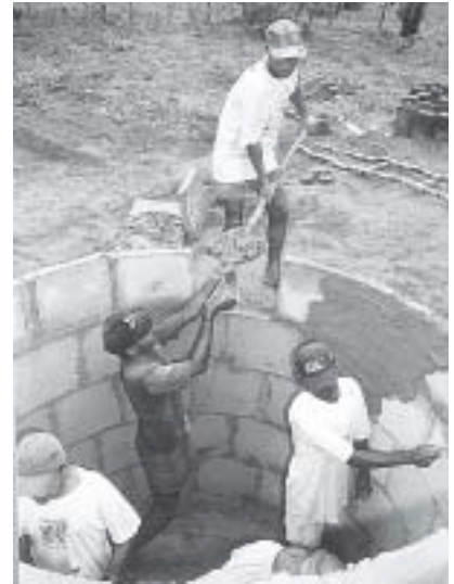
Beim Bau einer Zisterne.
